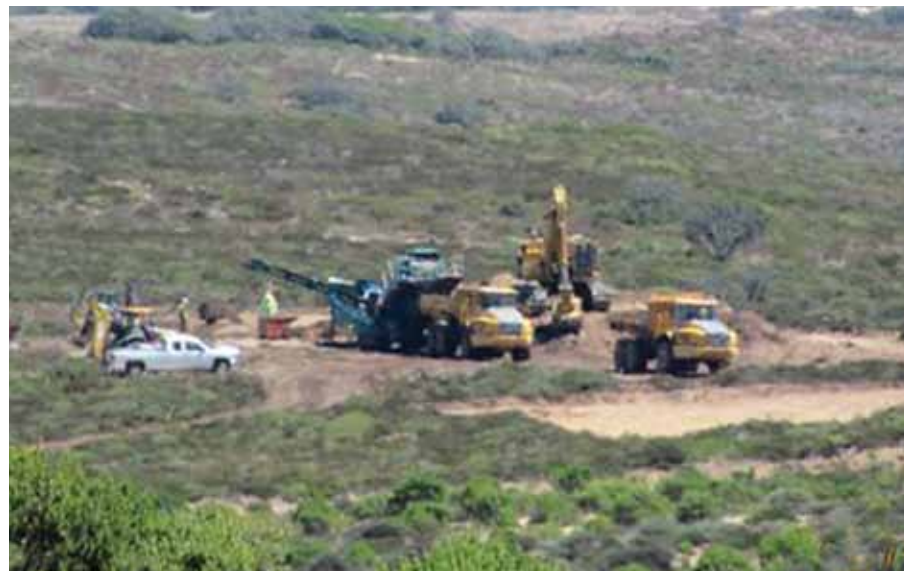
Excavación del suelo en el Área 39.
