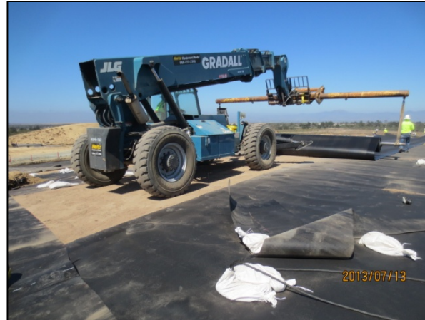
Rolling out geomembrane
