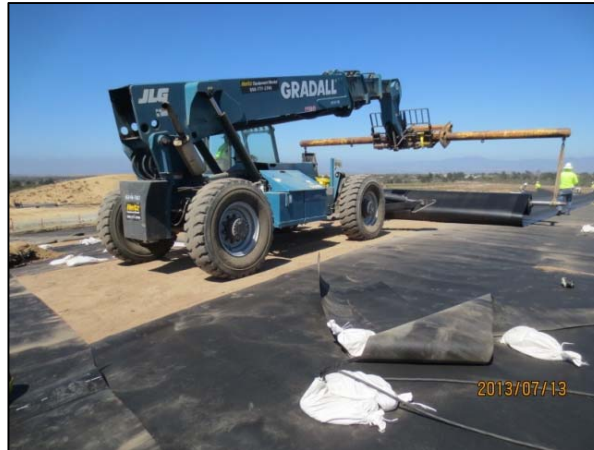
Rolling out geomembrane
