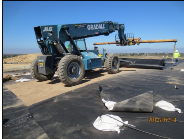
Rolling out geomembrane
