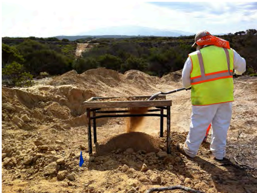
Pic 2: Sift table used in FEG MRA, parcel E11b.7.1.1 grenade range
