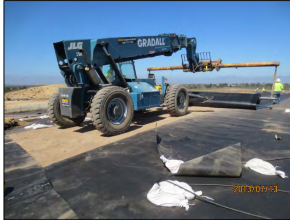
Rolling out geomembrane
