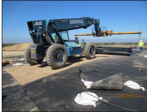
Rolling out geomembrane
